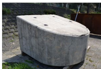
神戸橋の橋脚張出部 (CAESAR提供)
