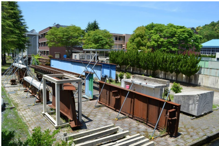
iMec全景・実物劣化部材実習フィールド
