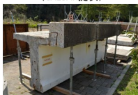
能生大橋の桁端部 (CAESAR提供)
