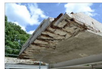
中国自動車道西下野高架橋 RC床版(NEXCO西日本)
