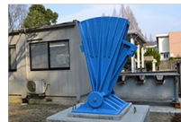
勝瀬橋の頭頂部サドル (CAESAR提供)
