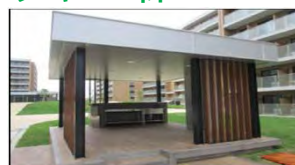
(屋外交流デッキ)
